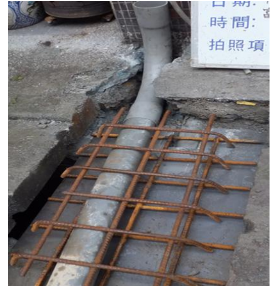
以鋼筋混凝土保護 並能承受外力之荷重
