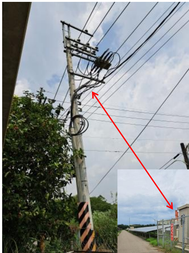
地下電纜電源線 併接點
