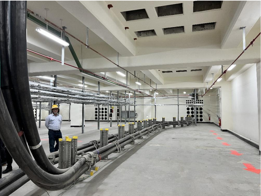
電纜整理室佈設消防管線(紅)
