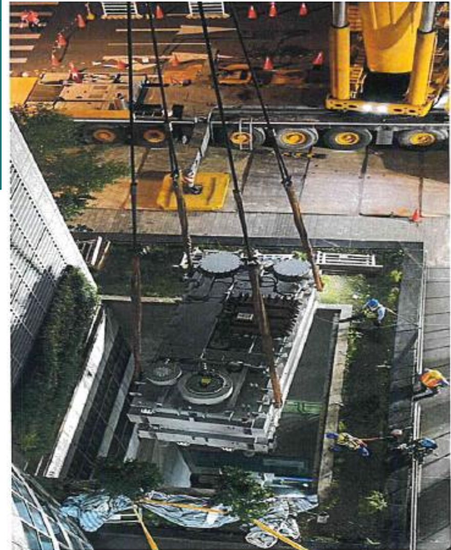
地下變電所 變壓器吊裝
