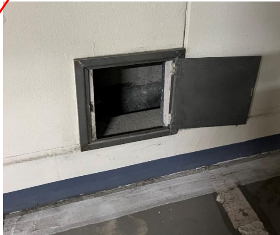
連續壁滲水觀測人孔
