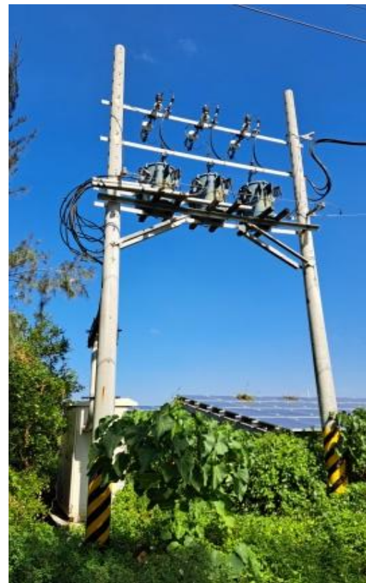
架空低壓併接點
