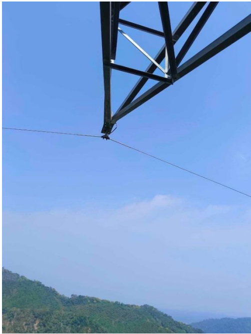
懸垂型鐵塔架空地線裝置
