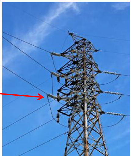
架空電源線T接
