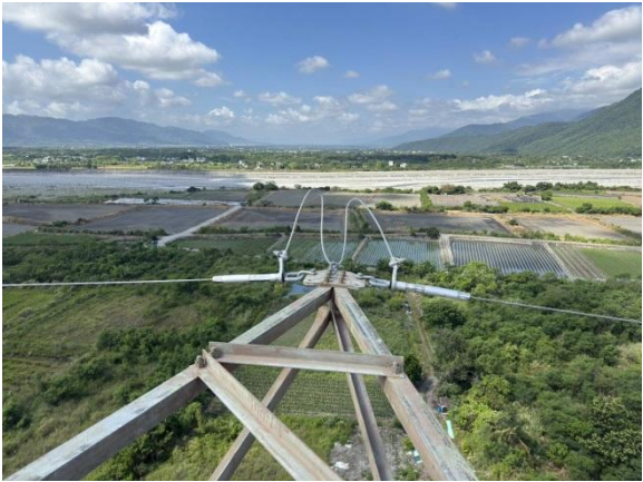
耐張型鐵塔架空地線裝置
