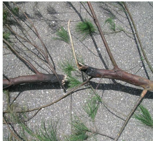
樹枝碰觸導線燒損斷裂 垂落線路造成短路斷線 停電事故。
