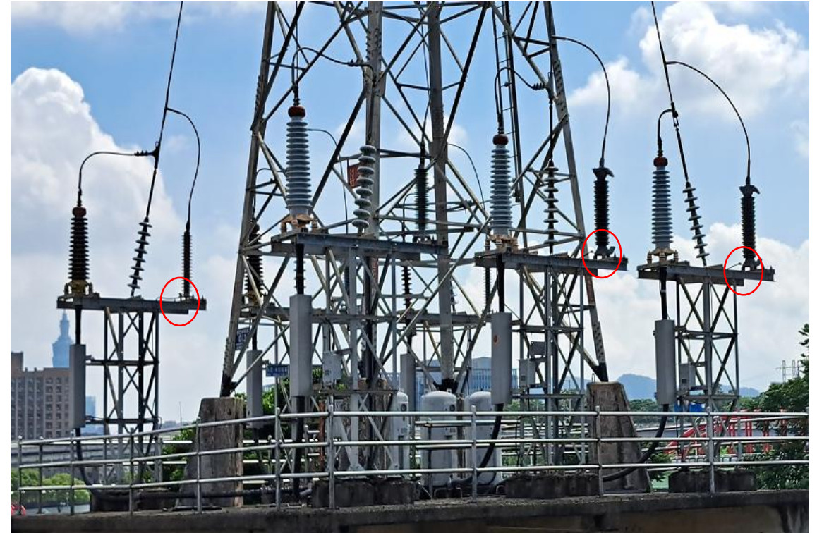
連接站避雷器接地線
