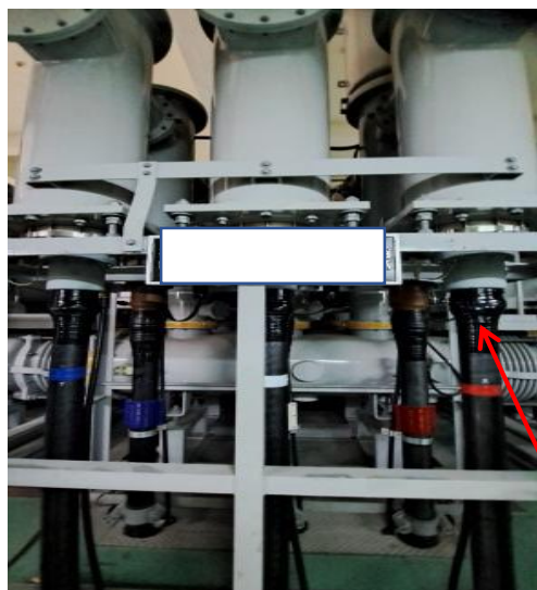
地下電纜電源線 併接點
