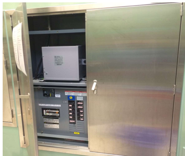
解說圖619：隔離電源系統
