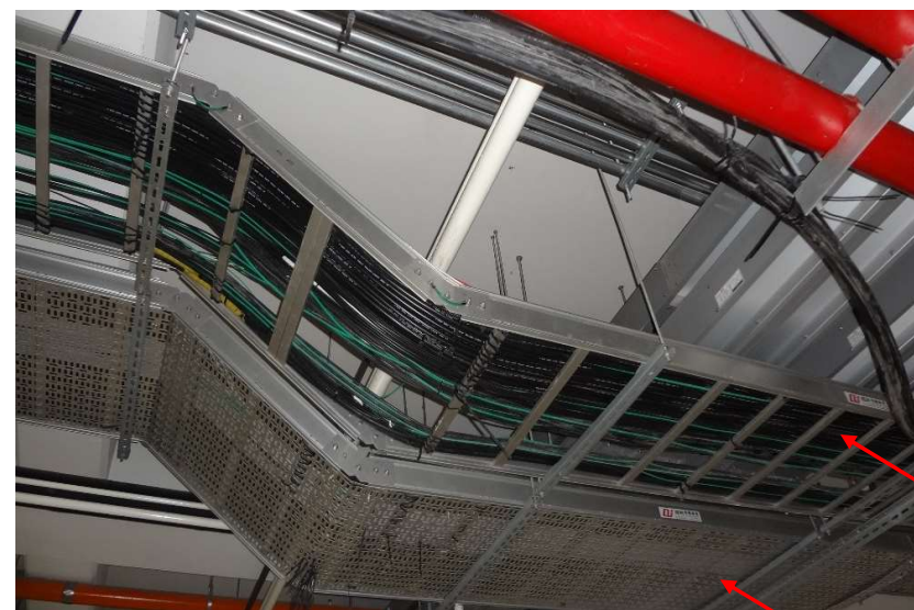
解說圖615：電纜架型式
