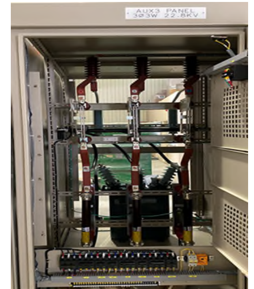
負載啟斷開關(附電力熔線)
